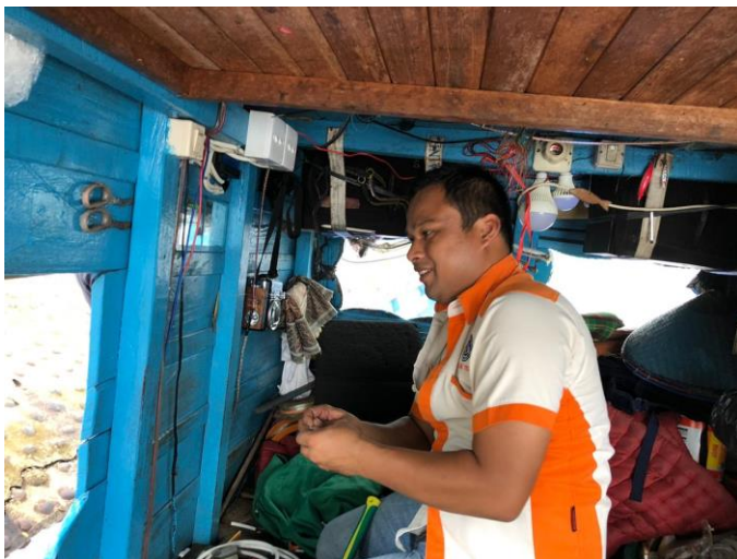
Gambar 2. Pemasangan Instalasi Kabel dan Sakelar Lampu Sorot pada Kapal
