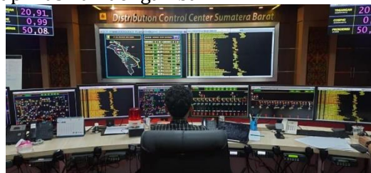
Figure 18. Alat Telah Dipasang Pada Ruang DCC
