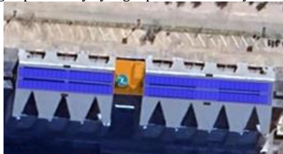
Gambar 2. Plotting Panel Surya Di Keseluruhan Atap Bangunan
