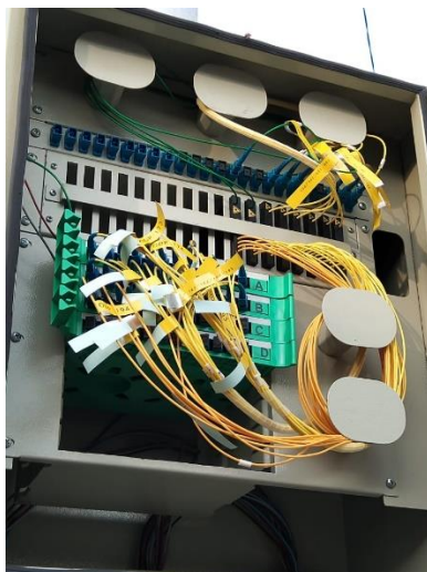
Gambar 3. Kondisi Saat Pengukuran di Lapangan
