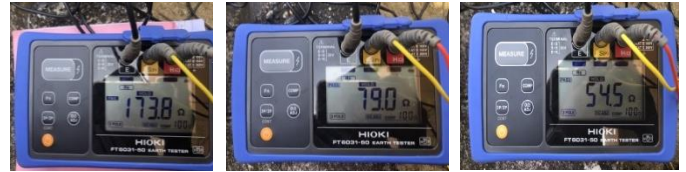
Gambar 2. Pengukuran Nilai Tahanan di Gedung Laboratorium Kimia FMIPA UNP
